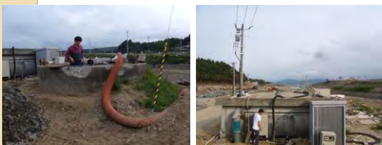
南三陸町助作水源（M1）の被災状況 [津波被災後の南三陸町助作水道水源の井戸の惨状。左が水源用浅井戸、右が海側の津波被災地（市街地）と本水源の現状。6月16日に河川・地下水質調査を実施。]
