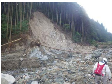
河岸の攻撃斜面の表層崩壊
