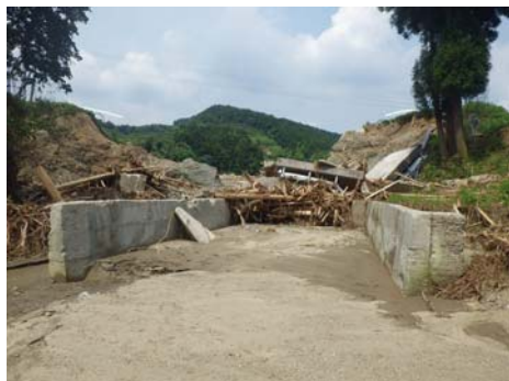
決壊したため池(下流から)
