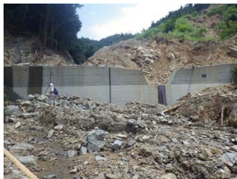
規模の大きい崩壊を止めた平成19年度治山ダム(クラックと目地の開きあり)
