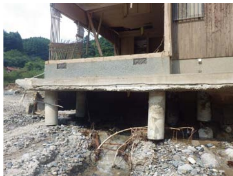
杭基礎が侵食された家屋
