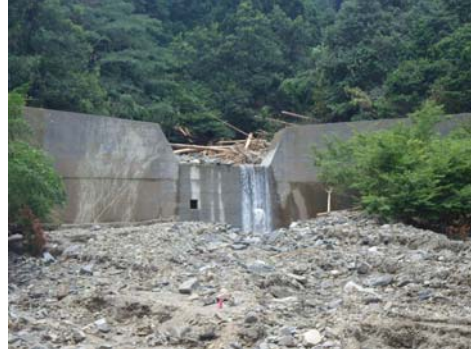
土砂や流木を捕捉している下流荒廃砂防堰堤(H=11m)空が満砂となる
