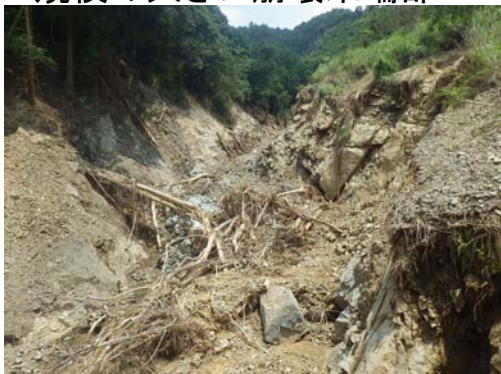
規模の大きい崩壊末端部
