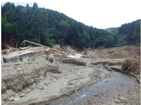
支沢からの土石流で倒壊した山尾坂砂防堰堤(H=10.5m)
