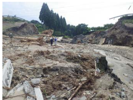
決壊したため池(上流から)
