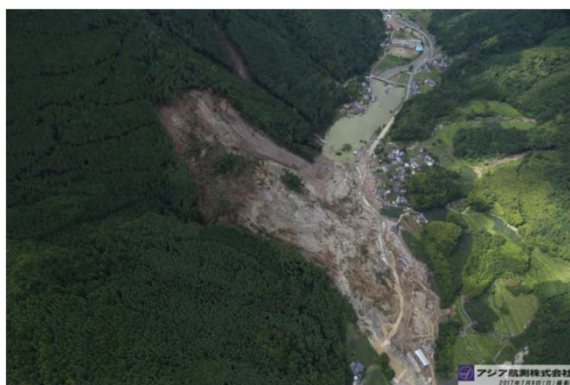
崩壊地全景(空から望む)
