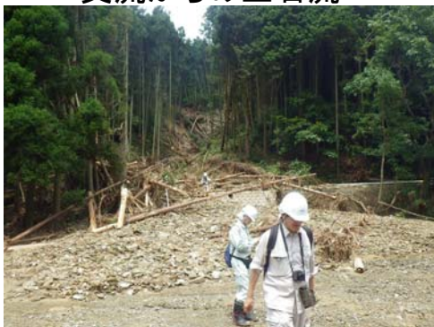
支流からの土石流
