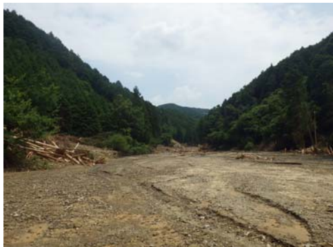
土砂や流木を捕捉している下流荒廃砂防堰堤(H=10m)空が満砂となる
