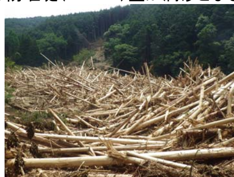
土砂や流木を捕捉している須川第一砂防堰堤(H=7m)空が満砂となる
