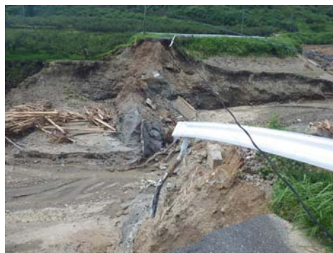
決壊したため池(横から)
