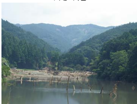
土砂や流木を捕捉している弘化3年のため池
